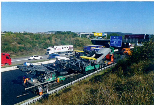
Einbau der Offenporigen Asphaltdeckschicht
