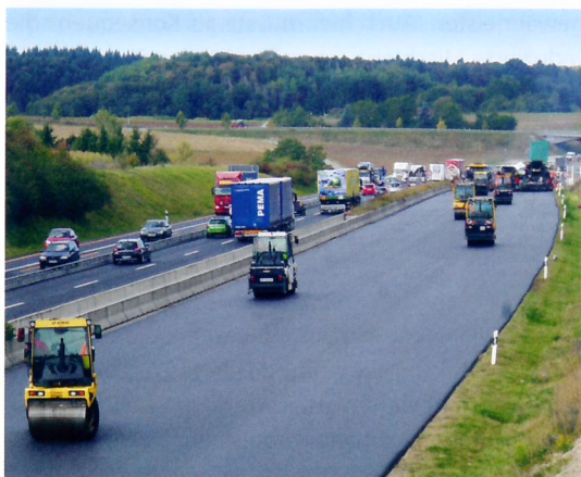
Bis zu acht Walzen sorgten für eine ausreichende Verdichtung und gute Ebenheit.
