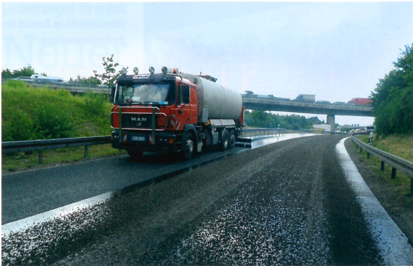
Abdichtung der Unterlage mit einer Bitumenschicht (SAMI-Schicht)
