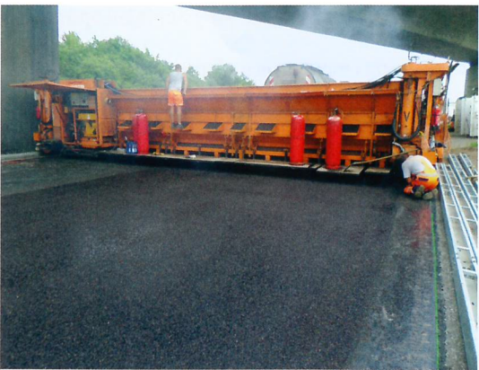
Einbau der Gussasphalt-schutzschicht im Bereich der Deckenerneuerung.
